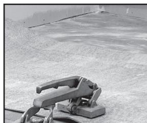
6. Una vez alineada correctamente la alfombra en el adhesivo húmedo, se requiere el uso de clavos de anclaje para sujetar la alfombra alineada hasta que el adhesivo haya fraguado totalmente. 24-36 horas.
