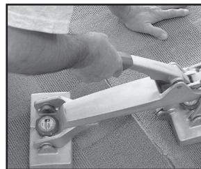
5. Appariez le motif au point central de la longueur du joint. Commencez au point central du joint jusqu'aux extrémités des joints. Rapprochez le motif à l'aide du 10-128.
